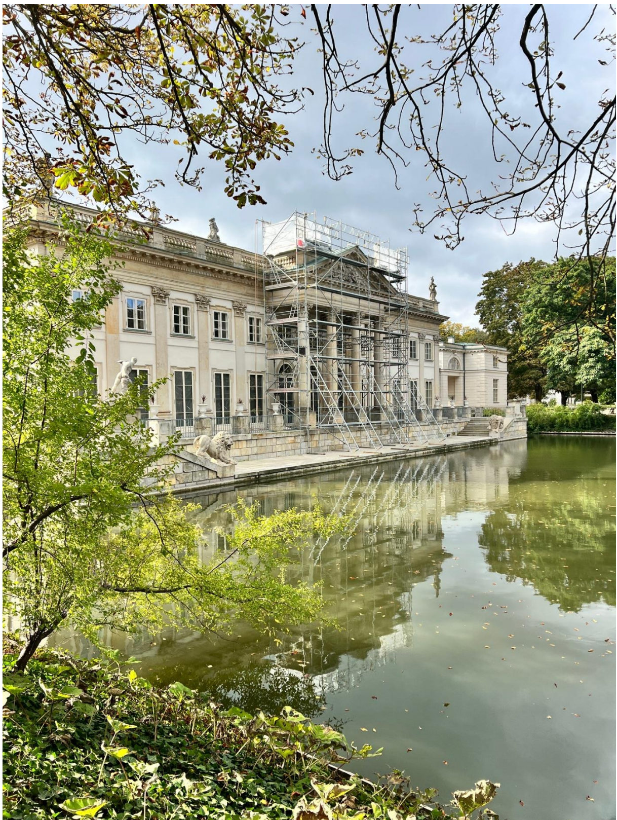
Rusztowanie ustawione w 2025 roku dla konserwacji dwóch rzeźb umieszczonych na skrajach tympanonu – północna elewacja Pałacu na Wyspie.. Zdjęcie poglądowe.
