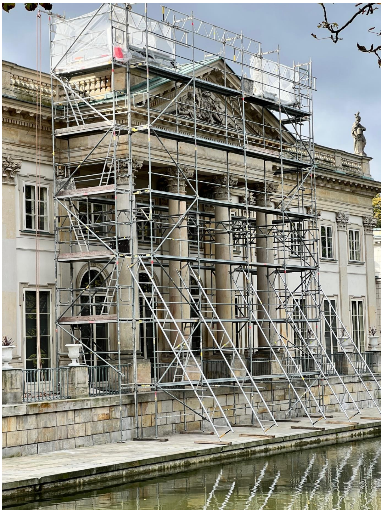
Rusztowanie na elewacji północnej Pałacu na Wyspie, zbliżenie. Wokół rzeźb zamontowane są balkony umożliwiające łatwy dostęp.
